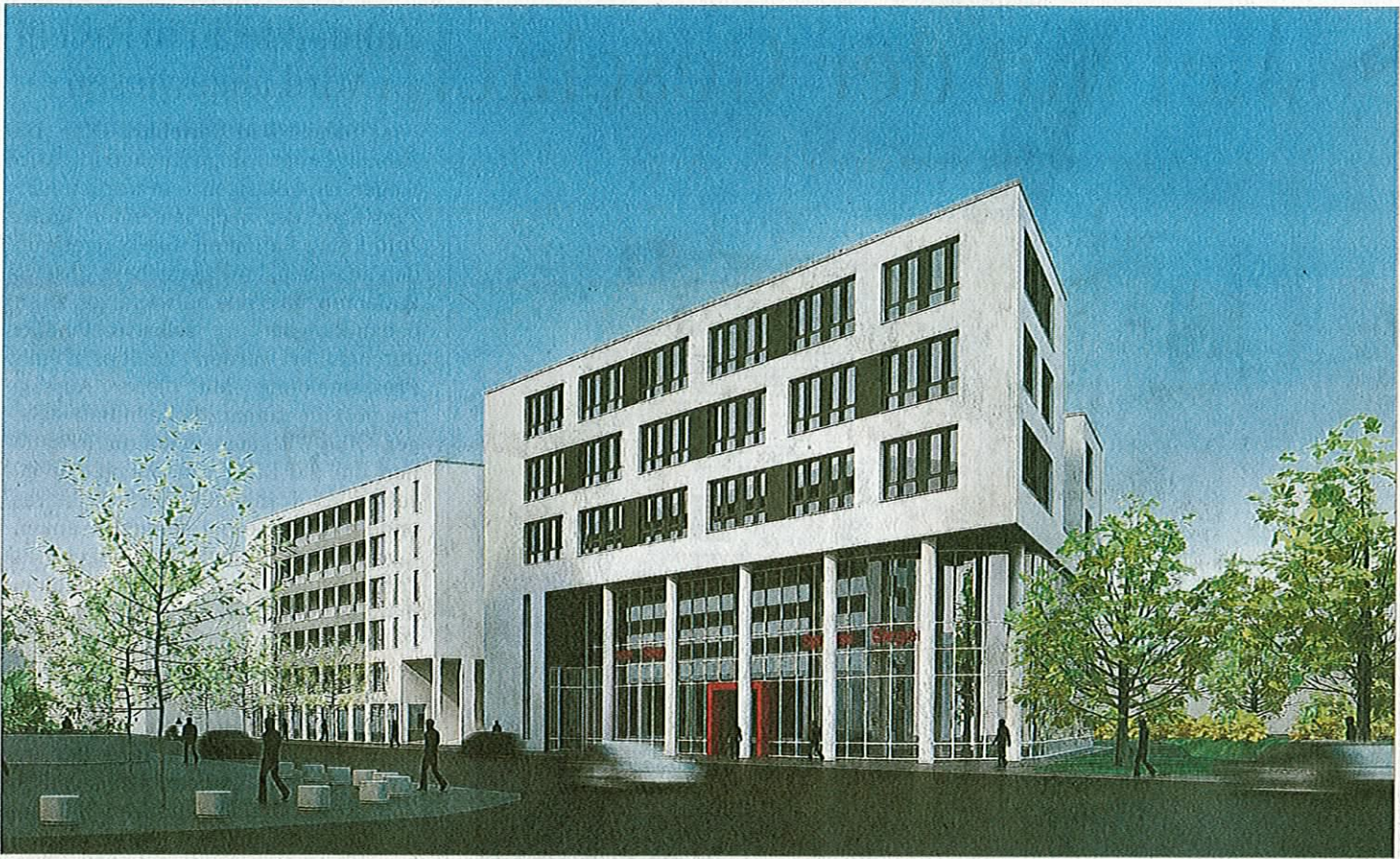
Bereits im ersten Quartal 2012 sollen die Arbeiten am Bauprojekt „Siegbogen“ an der Weidenauer Straße, gegenüber dem Rathaus Weidenau, abgeschlossen sein.
